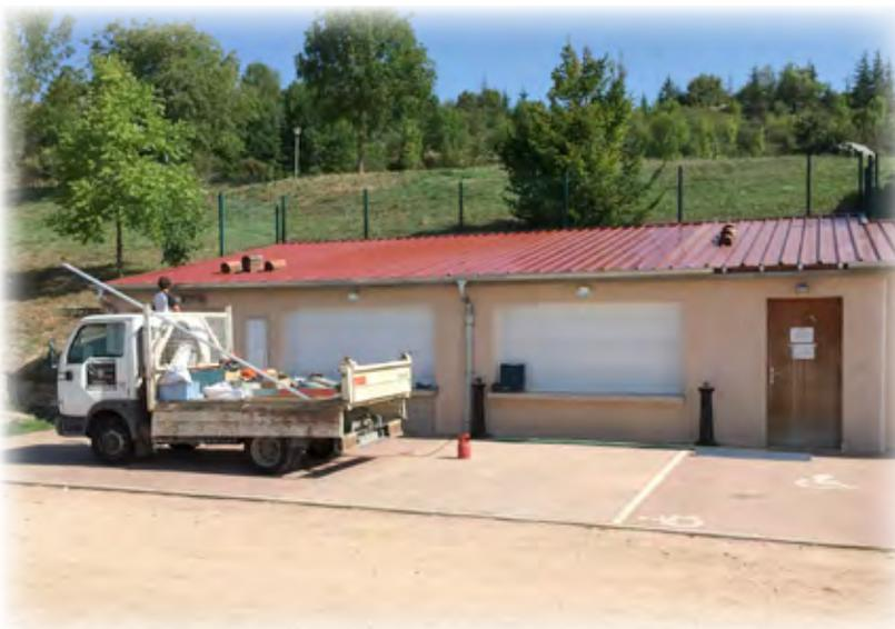
**A**u stade, la toiture des vestiaires a été rénovée en intégralité pour un coût de 18 000 €. De nombreuses tuiles cassées, ainsi que la sous-tuile souple devenue poreuse provoquaient, depuis longtemps d'importantes gouttières dans les locaux des vestiaires.
