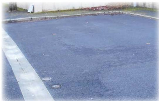
*Réhabilitation du parking avenue du Stade avec création d'une rigole pour l'écoulement des eaux pluviales.*
