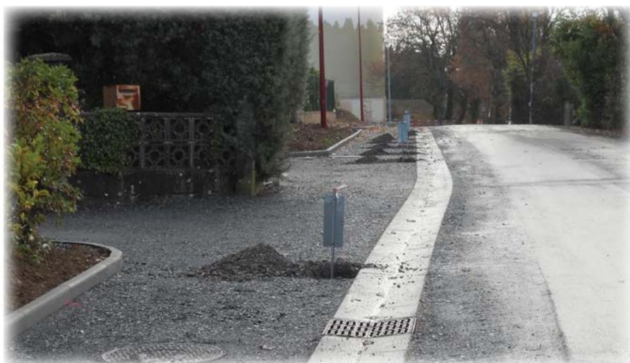
*Enfouissement du réseau électrique et téléphonique avec pose d'éclairage sur le chemin des Crêtes*
