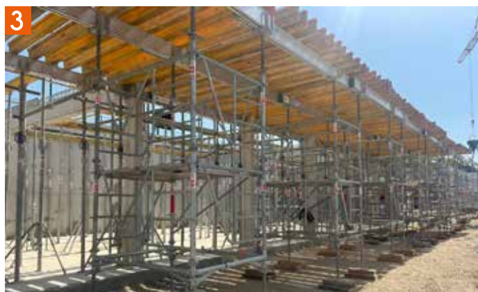
Préparation du coffrage de la casquette
