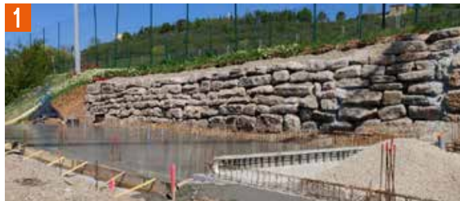
Première dalle coulée
