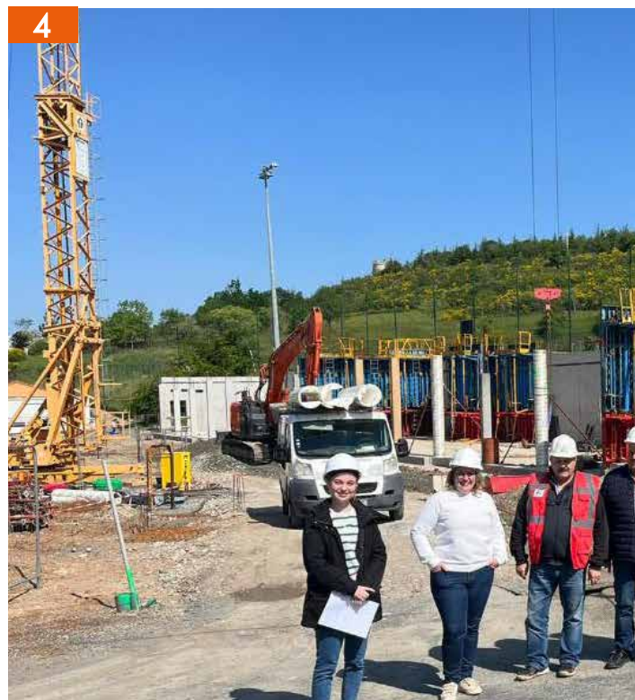
Elus et architectes en charge du suivi du chantier.
