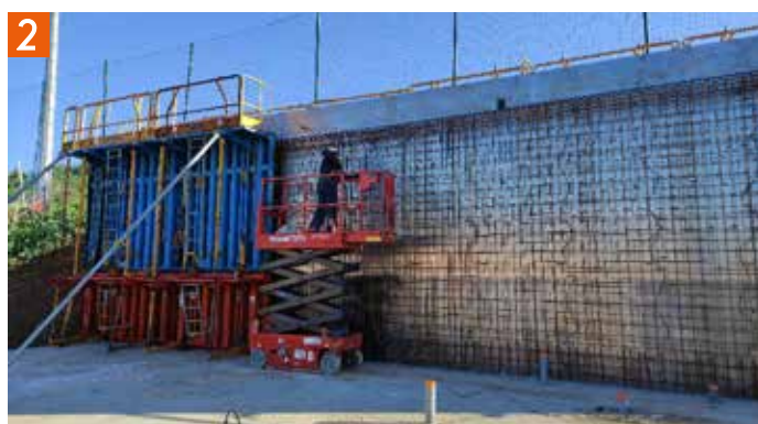
Premier mur en béton banché
