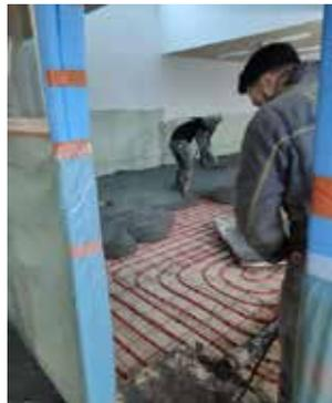
Béton quartzé sur plancher chauffant
