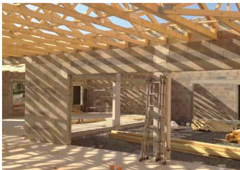
Les travaux avancent pour de meilleures conditions d'accueil et de prise en charge des personnes atteintes de la maladie d'Alzheimer
