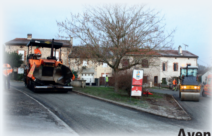
Réfection de la voirie
