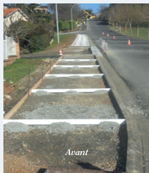
Réalisation des trottoirs
