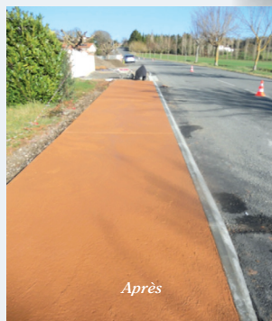
Pose de revêtement en béton coloré
