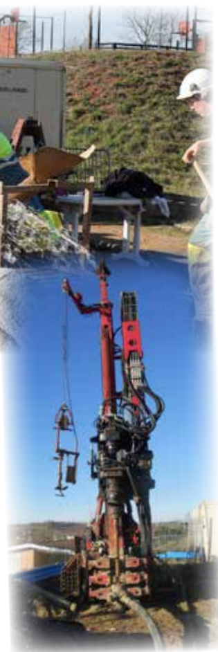
Forage d'un puit à côté du terrain d'honneur pour l'arrosage de la pelouse
