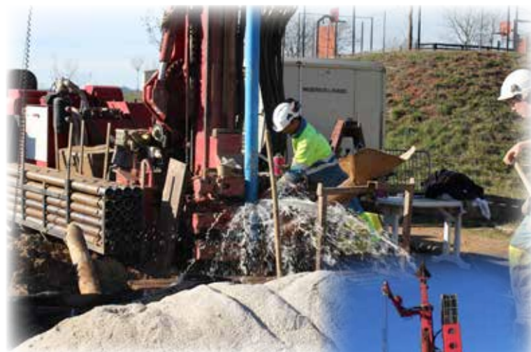
Forage d'un puit à côté du terrain d'honneur pour l'arrosage de la pelouse
